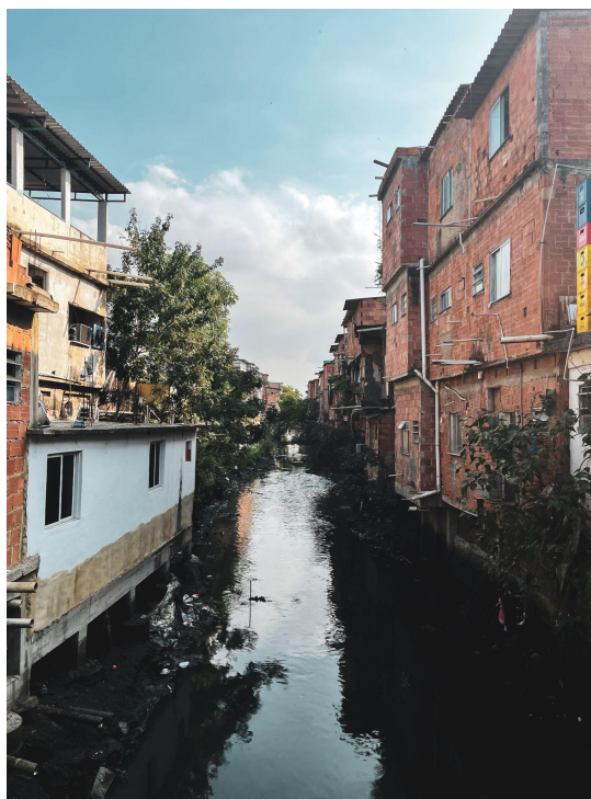
Figura 10 - Conexões entre esgoto e rio na Maré
